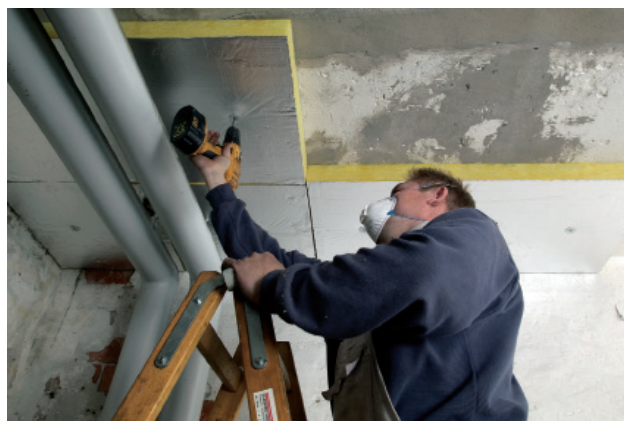
Pladerne monteres direkte i betonen ved hjælp af to specialskrue, som ikke kræver rawlplugs.
